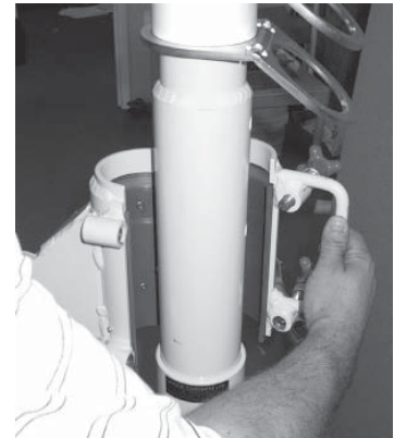
Figure 11 : Installation du mât d'ancrage
